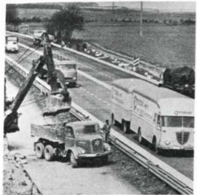
DIE BAUARBEITEN können ausgeführt werden, ohne daß der laufende Autoverkehr behindert wird. Im 50-Kilometer-Tempo flitzen die Autos dank Stahlflachstraßen an der Baustelle vorbei. (Bild oben)
