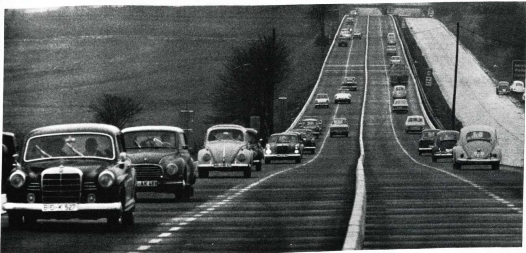
VERKEHRSPROBLEME werden zunehmend mit Hilfe des Stahlbaues gelöst. Stahlflachstraßen ermöglichen, wie dieses Modell zeigt, trotz Straßenarbeiten einen ungehinderten Verkehr. (Bild oben)
