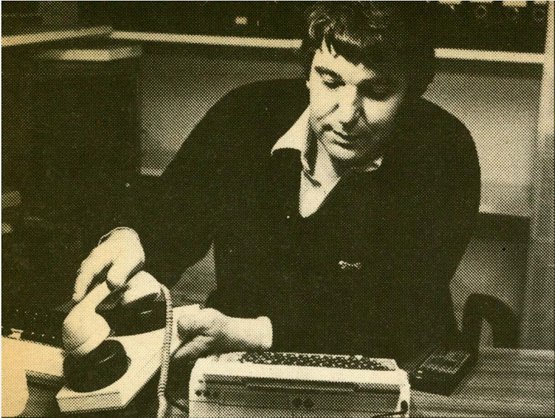
Der Telefonhörer wird einfach in den Akustik-Koppler reingedrückt.
