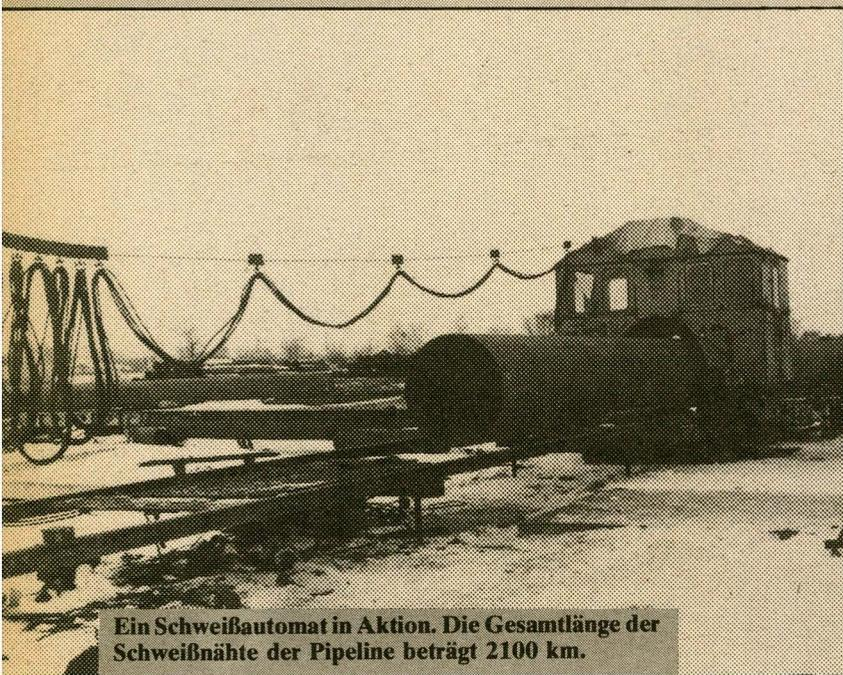
Ein Schweißautomat in Aktion. Die Gesamtlänge der Schweißnähte der Pipeline beträgt 2100 km.
