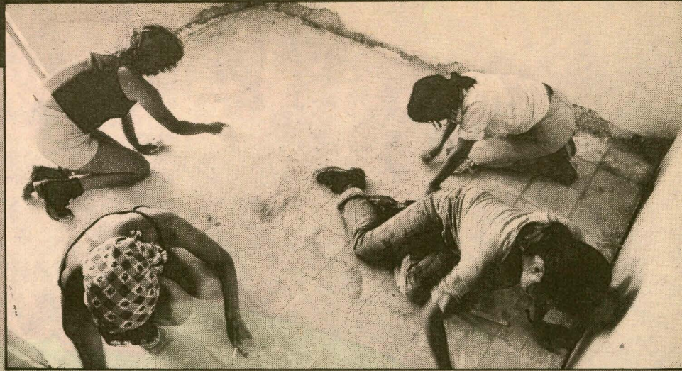
In dieses Haus, dessen Fußbodenkacheln hier sorgfältig verputzt werden, ziehen nach der Fertigstellung die Arbeiter des benachbarten Textil-
