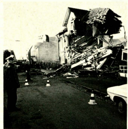
Siegen: Jugendliche hatten dieses Haus besetzt und als Jugendzentrum hergerichtet. Sie wurden von der Polizei vertrieben. Der Bagger machte dann das Haus dem Erdboden gleich.
