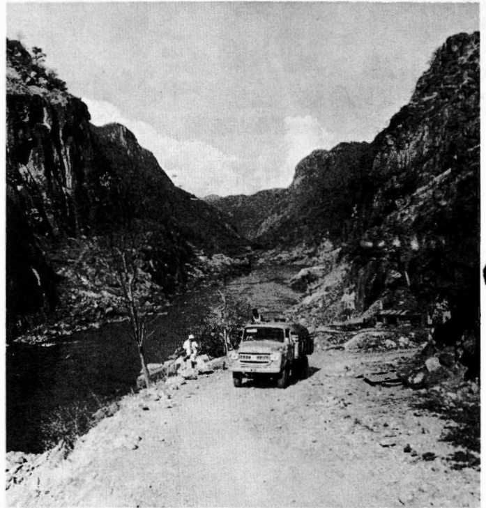
Hier soll nach den Plänen der portugiesischen Kolonialisten der Cabora-Bassa-Staudamm entstehen.
