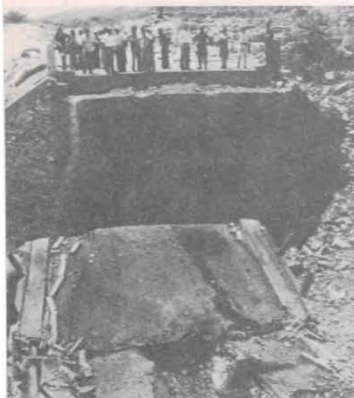
Von südafrikanischen Truppen zerstörte Brücke in Angola
