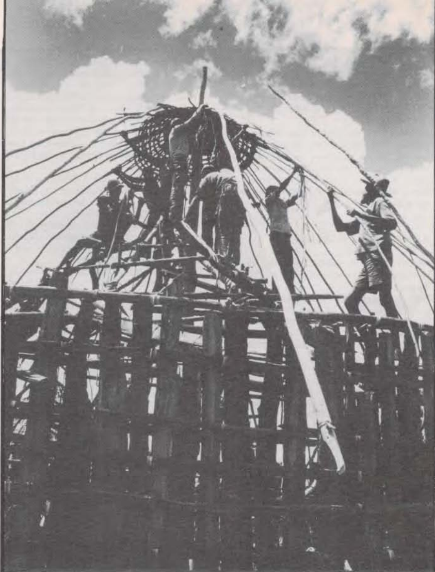
Gemeinsamer Tukulbau im Neusiedlungsgebiet Dembidollo
