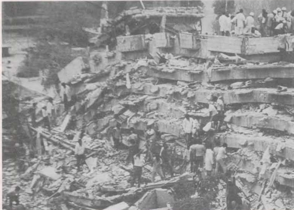
Schwere Fabrikmaschinen in Wohngebäuden trugen mit zu ihrem Einsturz bei
