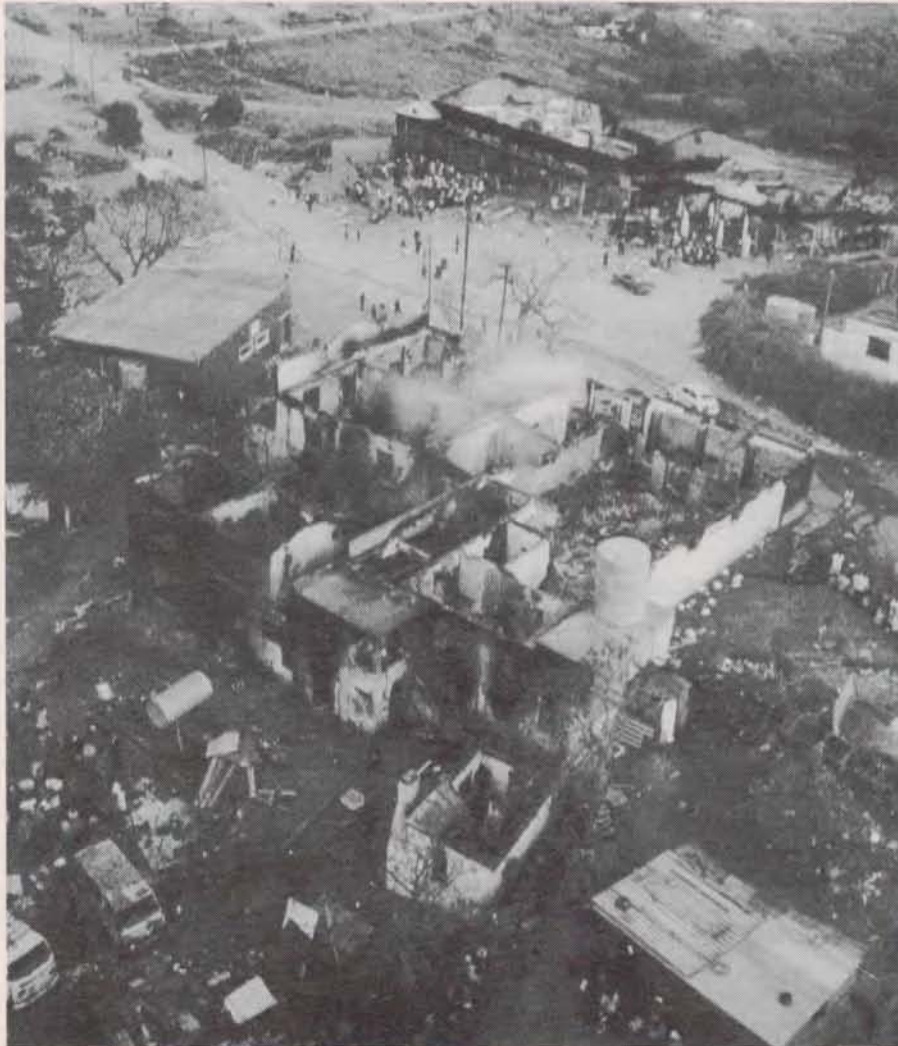
Ausgebrannter indischer Supermarkt in Inanda, südlich von Durban
