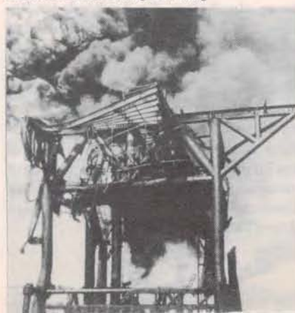
Zerstörte iranische Ölanlage bei Kharg
