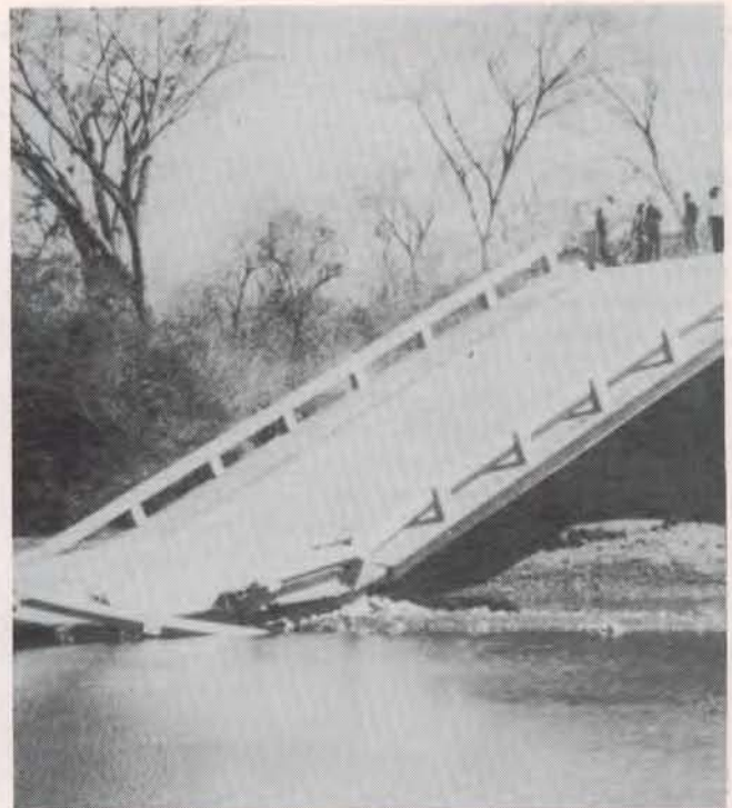
Rio-Negro-Brücke, zerstört von Somozisten
