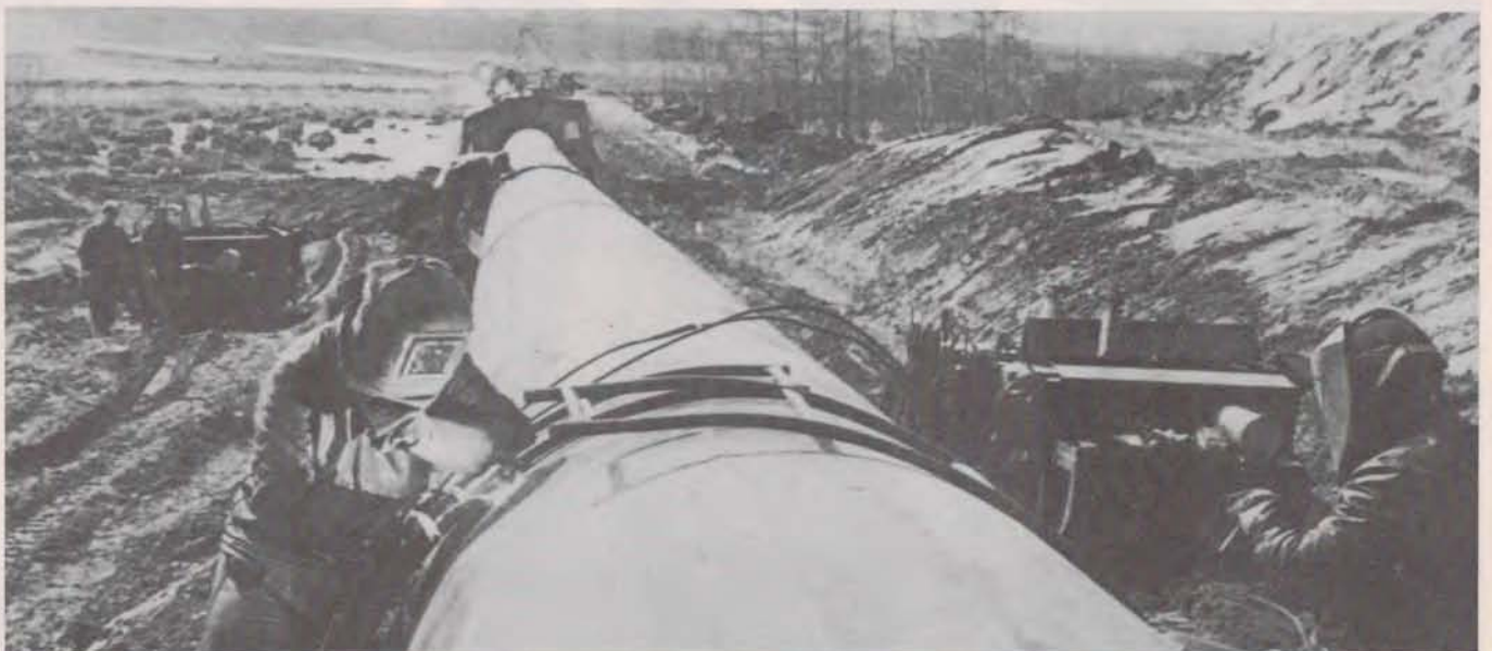
Sowjetische Arbeiter beim Bau einer Erdgasleitung nach Westeuropa
