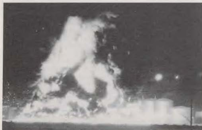
Brennende Tanks der Kohleverflüssigungsanlage SASOL II
