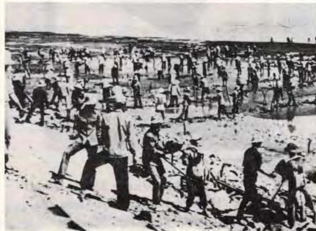
Arbeitseinsatz im Mekongdelta: Bau neuer Bewässerungssysteme
