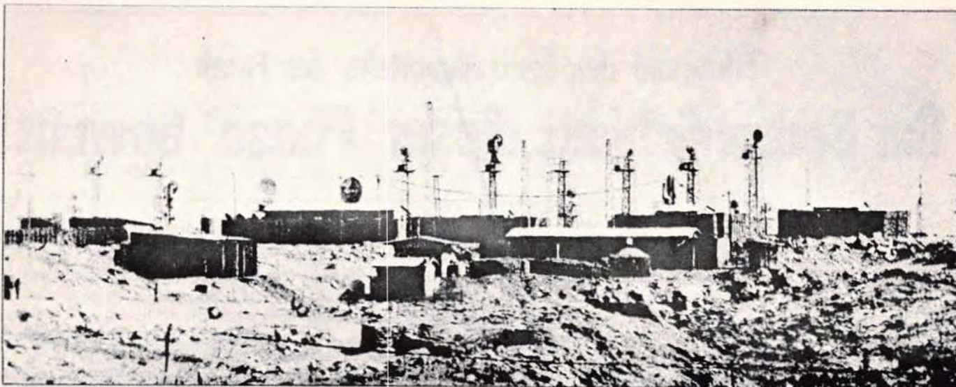
US-Kontrollstation am Sinai
