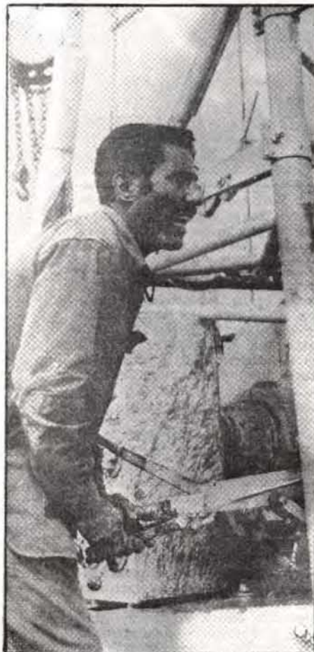
Brunnenbau für die Trinkwasserversorgung – eine dringende Aufgabe. Bohrmeister Ahmed al-Hassani arbeitet am Br. Nasser in der 2. Provinz.
